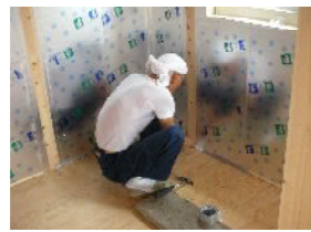
工事中 見学できます
