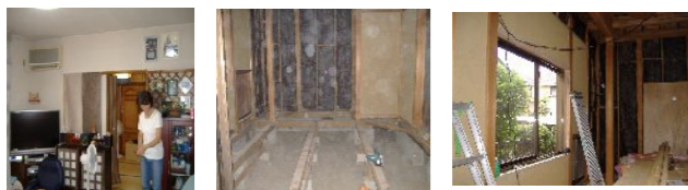
リフォームの内容・・・和室を洋間に改装し、居間と続きに和室の西壁には中窓を新たにもうけました。
